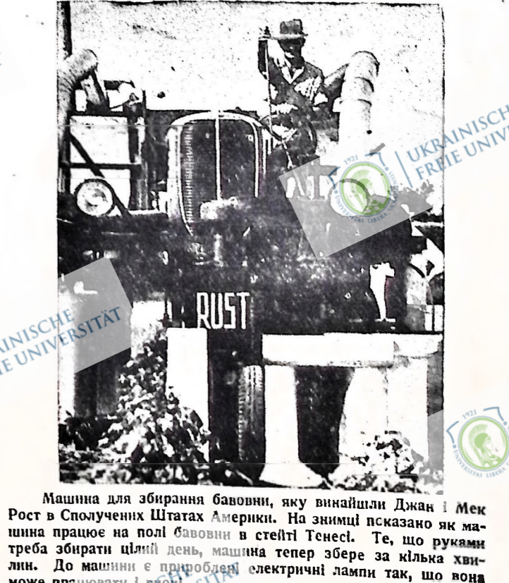
Машини для збирання бавовни, яку винайшли Джан і Мек Рост в Сполучених Штатах Америки. На знімці показано як машина працює на полі бавовни в степі Тенесі. Те, що руками треба збирати цілий день, машина тепер збере за кілька хвилин. До машини є прироблені електричні лампи так, що вона може працювати вночі.
